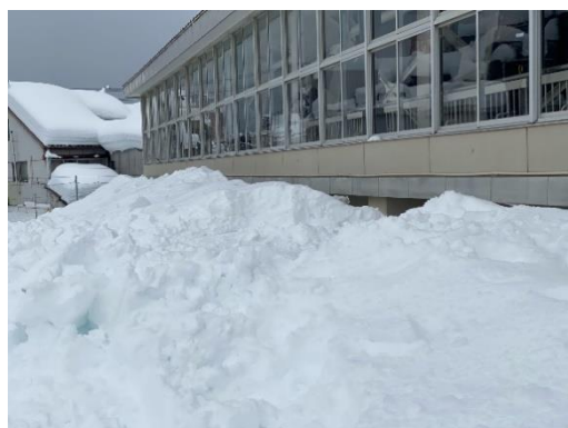
体育館の屋根からの落雪もあり、 ギャラリーまで雪が迫りました。
